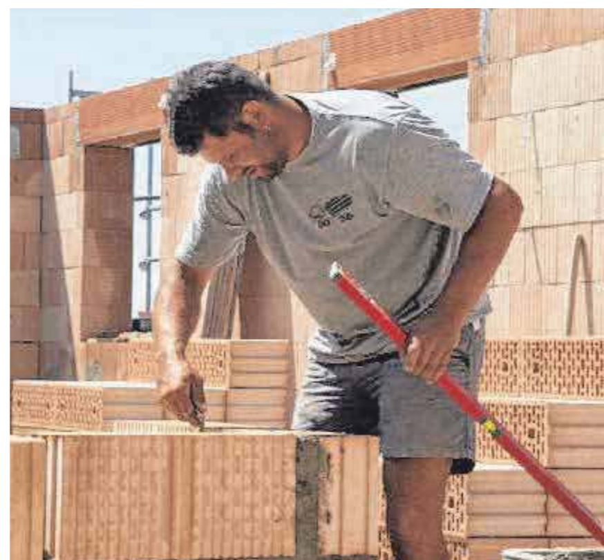
Christof Embritz bei der Arbeit auf einer Baustelle in Hergensweiler.
