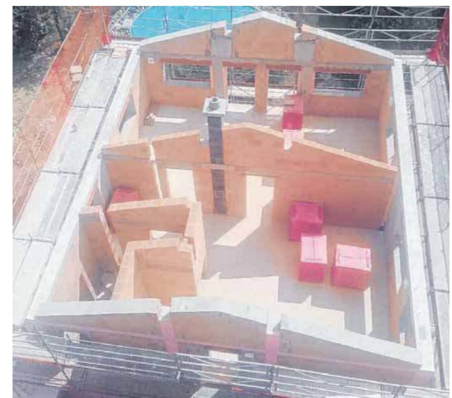
Baustelle des Bauunternehmens August Blaser mit Inhaber Christof Embritz. FOTO: PRIVAT
